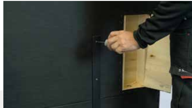
Schrauben Sie die drei Verbindungsstücke aus Metall ab
